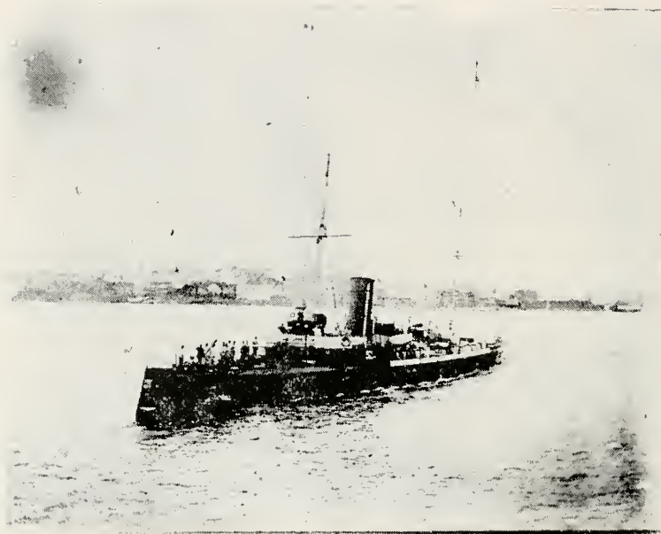
Минный крейсер „Абдуль“ (Построенъ въ 1896 г. на заводѣ Крейтонъ въ Лбо. 675 тоннъ. 21 узелъ. 2-75 м/м и 1-47 м/м пушки. Экипажъ 79 человекъ).
